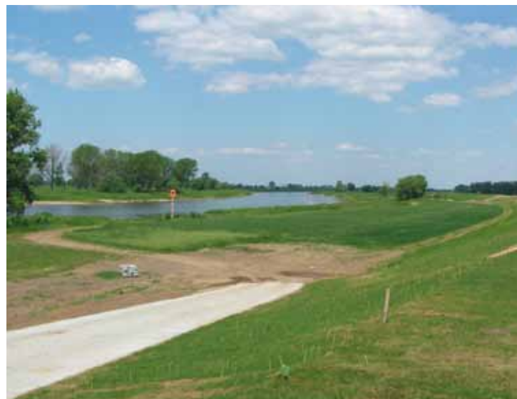
Hochwasserschutzdeich an der Elbe
